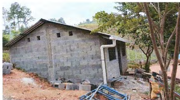
Foto 2: Instalación de bajada de agua pluvial.
