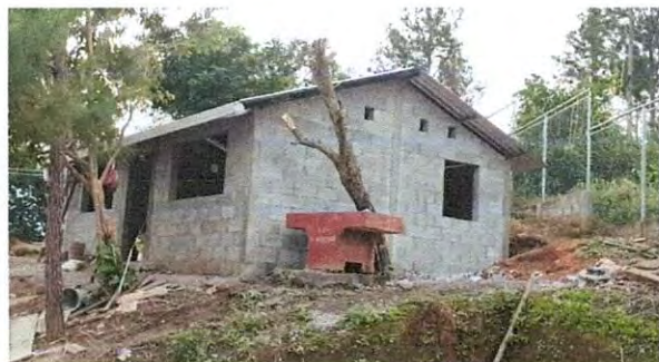
Foto1: Instalación de canal de agua pluvial
