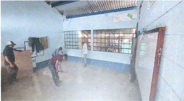
Foto 3: Continúan las labores para eliminar la capa de piso dañado.
