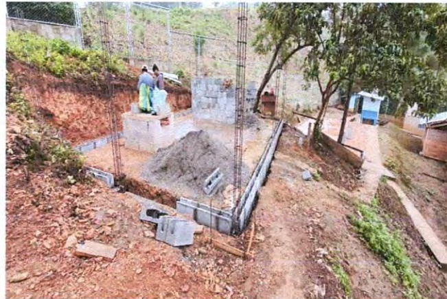
Foto 2: Colocación de cemento corrido, estructura de columnas y fundición de primera solera.
