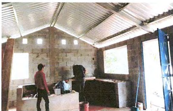
Foto 3: Instalación de banco de trabajo.
