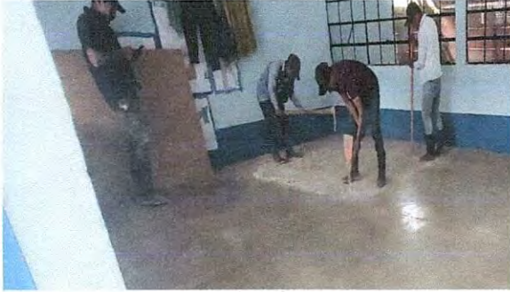
Foto1: En el módulo de aula 3 se inicia con el picado de piso previo a la instalación del piso cerámico.
