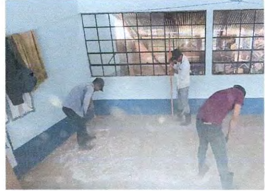
Foto 2: Continuidad para finalizar el picado total de la capa de piso dañado.
