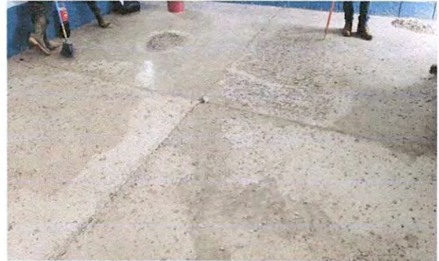
Foto 4: Finalización a la fase de picado del piso.
